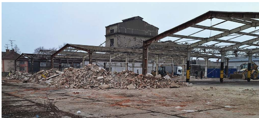
Demolice starých objektů bývalé Fruty 3
