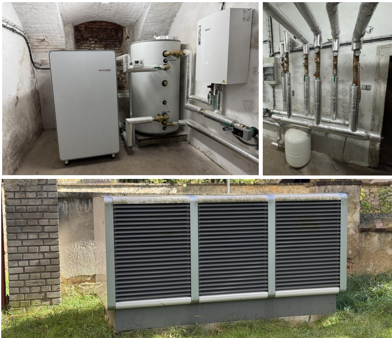
Obrázek 12 Ukázka tepelného čerpadla země-vzduch zásobující teplem budovu
