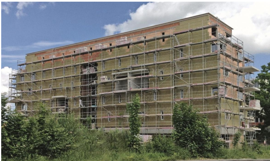
Obrázek 11 Ukázka zateplení fasády minerální vatou
