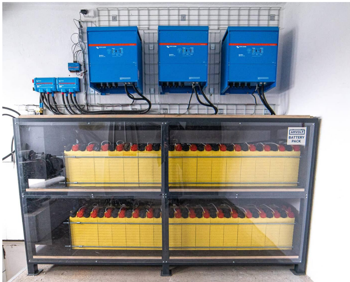
Obrázek 15 Sestava pro solární aplikace, střídače a baterové úložiště 100 kW
