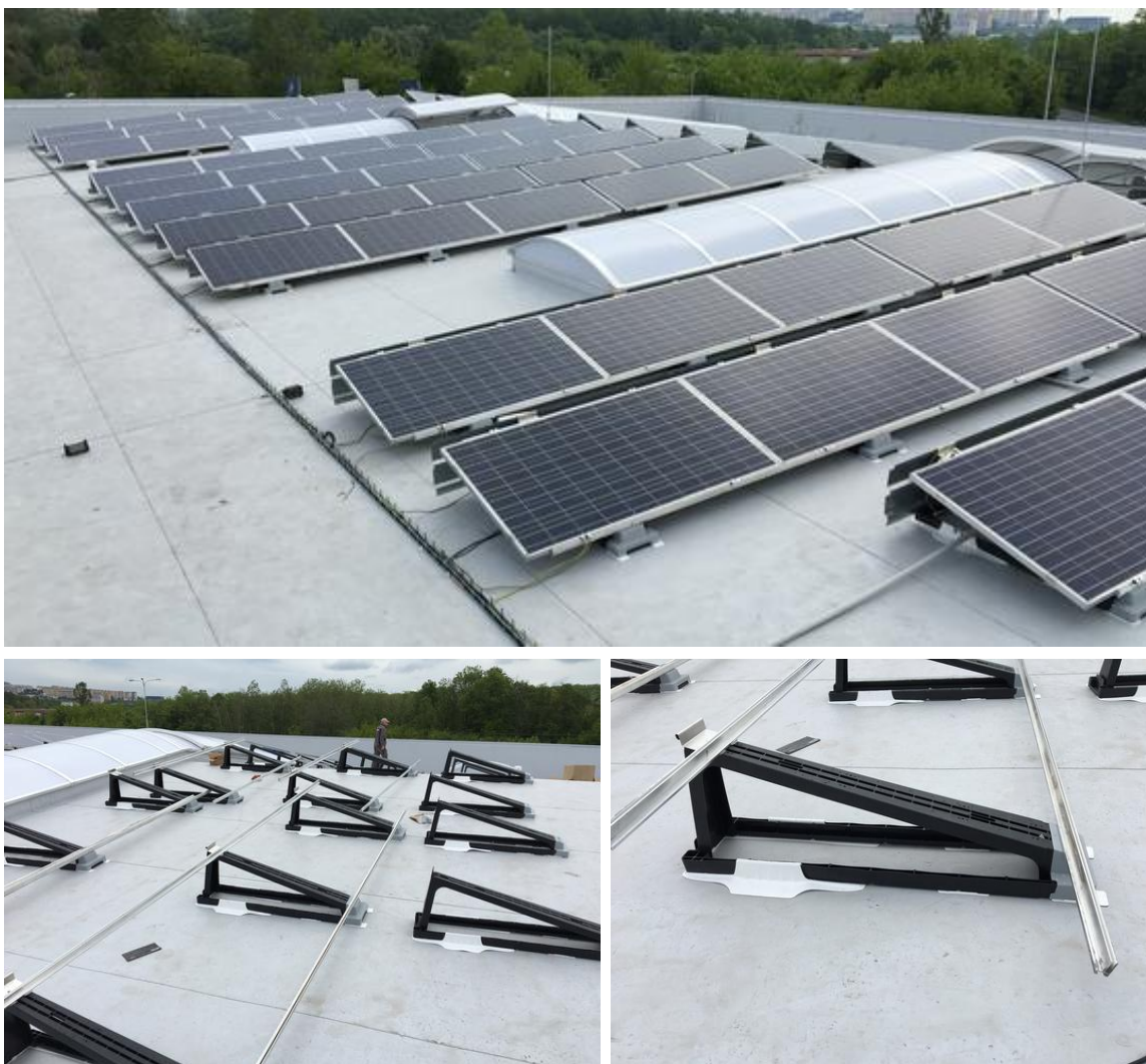
Obrázek 14 Instalace solárních panelů na ploché střeše
