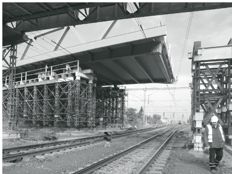
Přesouvání nového mostu bez výluky na trati Foto: M.Hájek
