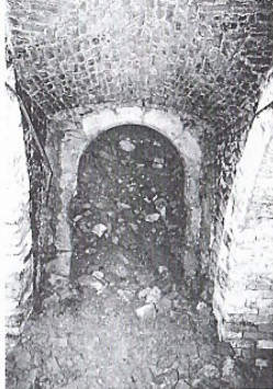
Původní vstup do renesančního sklepa pod východním křídlem
