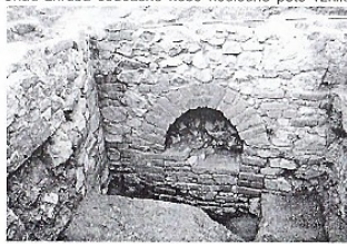
Pohled na odkrytou část pozdně středověkého sklepa
