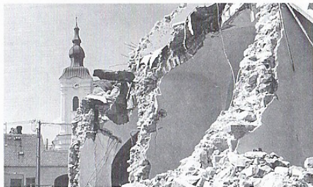
Demolice nejstarších zdív radnice
