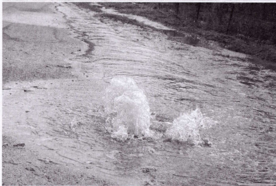
Horní snímek ukazuje kritické místo, kde došlo k přetečení náhonu. Spodní „fontánku“ vytékající kanalizace. Fotografie J. Tůma
