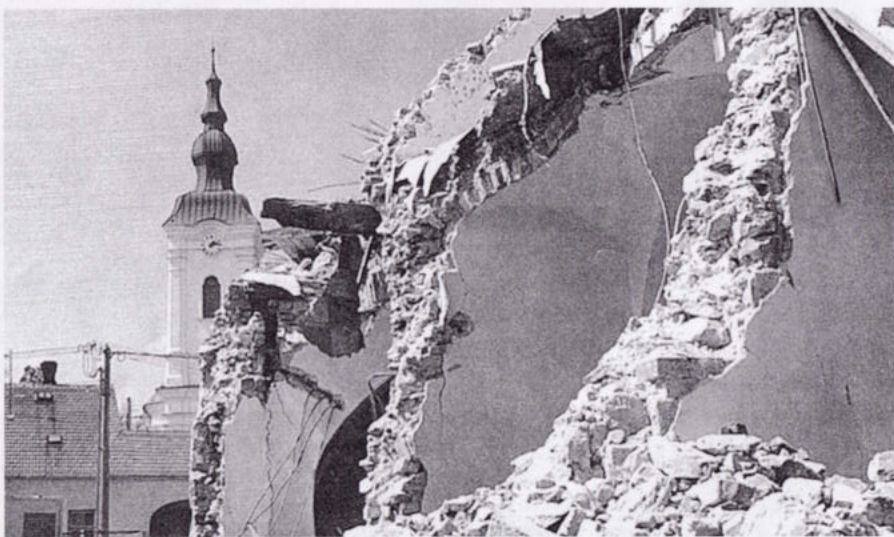
Demolice nejstarších zdí radnice
